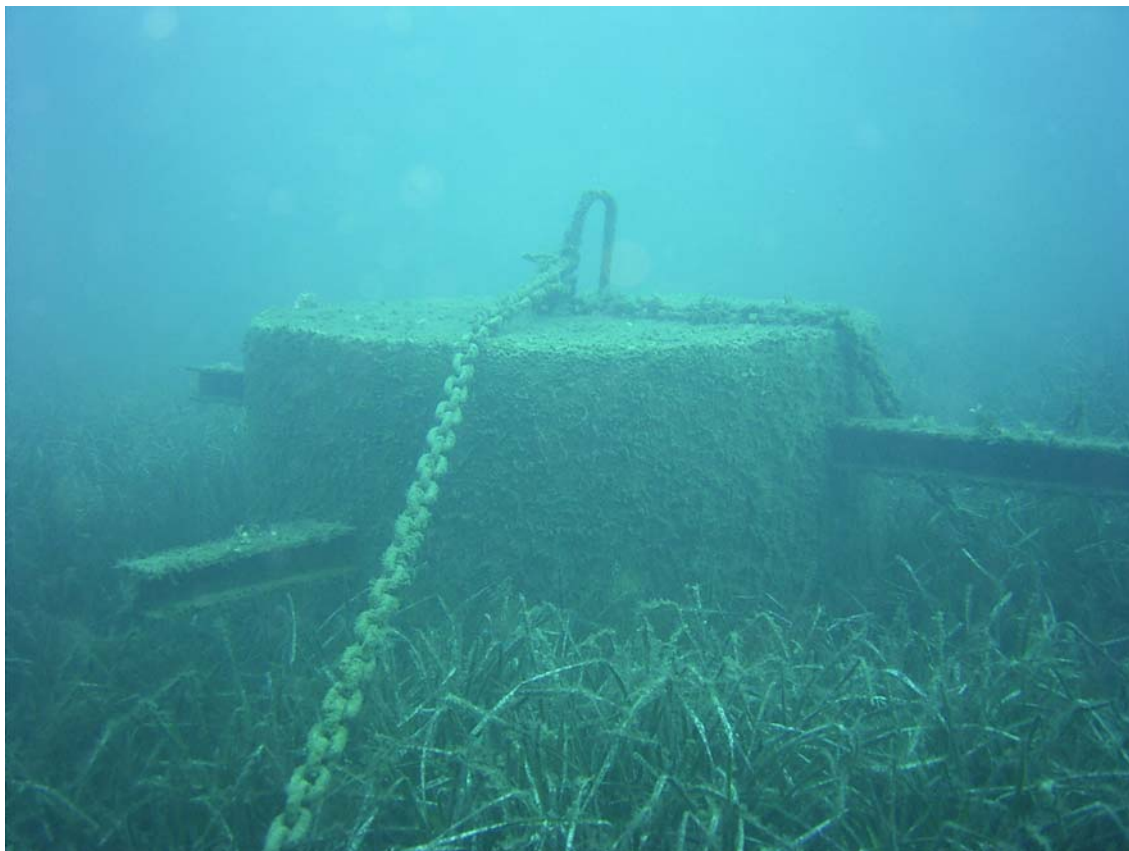
Arrecife antiarrastre unido con cadenas para proteger la boca del emisario y los fondos de Posidonia adyacentes.
