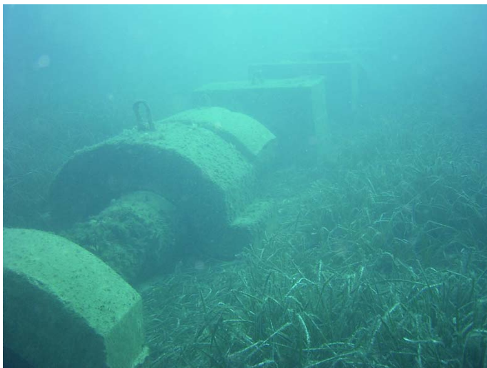
Emisario sobre Comunidad de Posidonia oceanica a 15 m de profundidad
